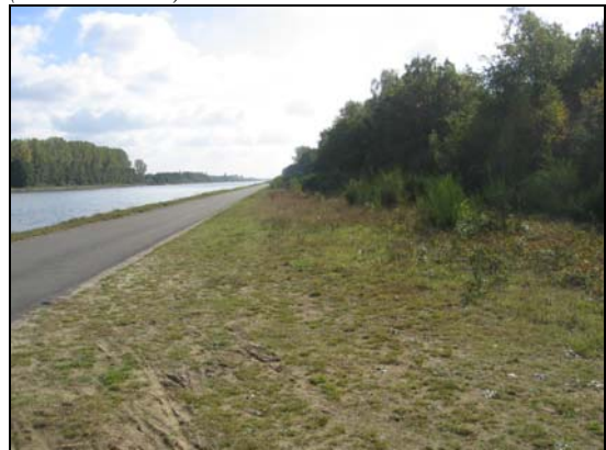
Schrale bermen langs het Albertkanaal
